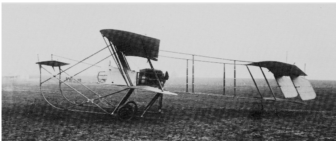
Biplan MF-2 à moteur Renault 60 ch (1910) dérivé du MF-1 de 1909. (Cliché S.H.A.A.).
