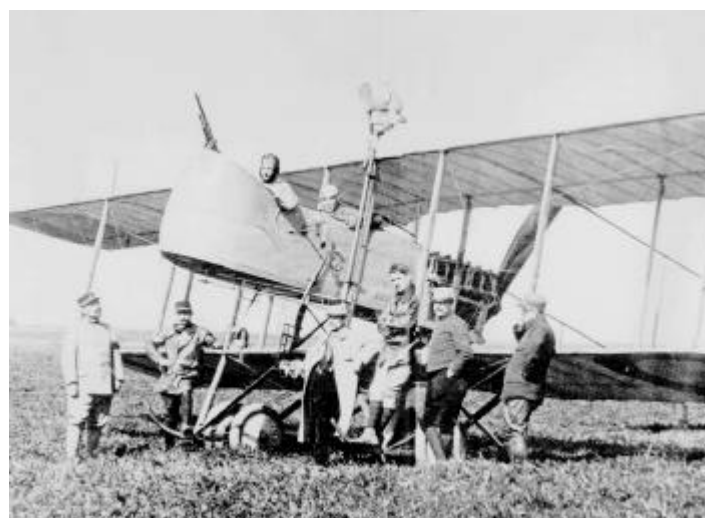
Biplan Maurice Farman MF-11 à moteur V12 Renault de 130 ch (1916). (Cliché Musée de l'Air).
