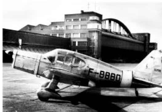
Le SE-2300 dernier appareil à moteur Renault devant des bâtiments de la SNCASE à Toulouse.
